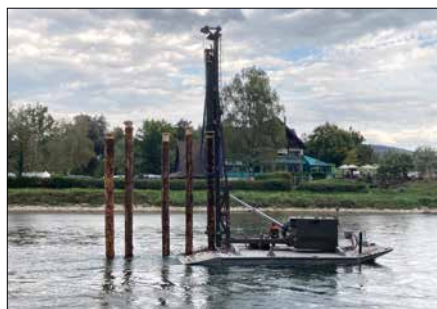
Schwimmende Ramme, mit Blick auf das Rest. Reussbrücke
